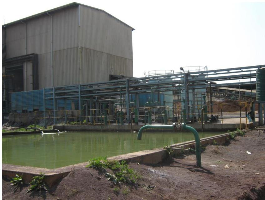
**Figure 12. Eau de granulation de la scorie à recycler.**
