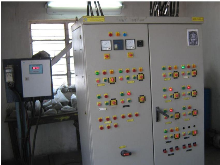
**Figure 7. Armoires de commande pour les fours**
